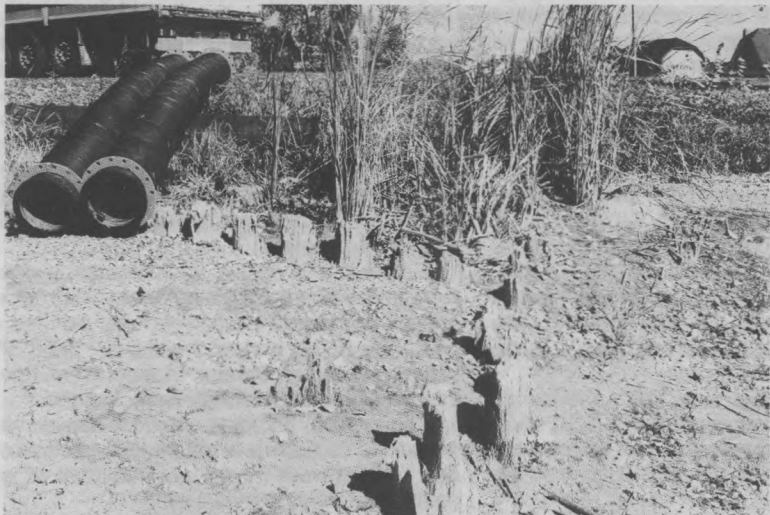
До сих пор берега павловского пруда укрепляют деревянные сваи, забитые много лет назад (снимок сделан в 2013 году, во время понижения уровня воды перед началом очистки пруда)
