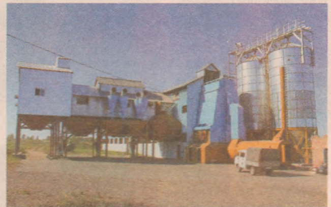
В этом году в хозяйствах района обновляли зернохранилища и сушильные мощности
